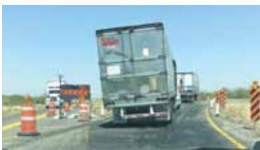
Desviaciones en la Cuatro Carriles...riesgo fatal.
